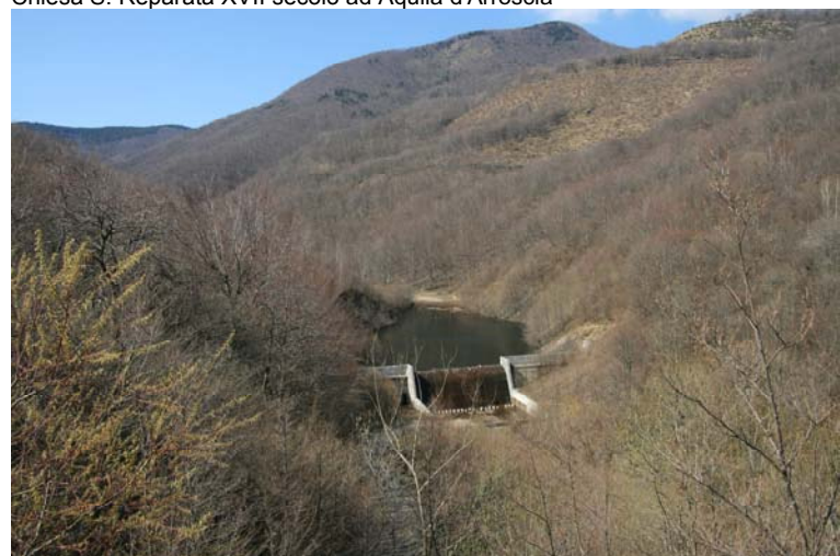
Diga sul rio Ferraia
