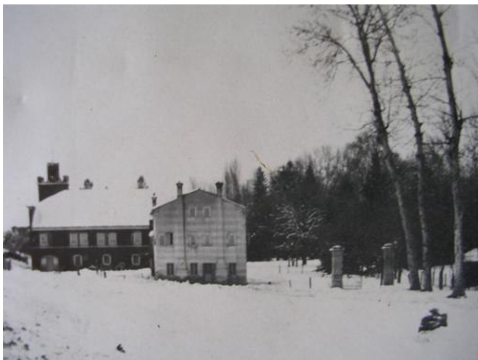
Villa Camerini poco prima di essere demolita
