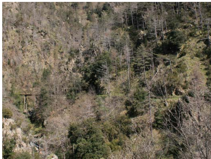
il ponte presso la presa d'acqua di Ruggi
